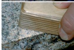
Überschüssiges Material mit **AKELUX** Hobel abnehmen. Für Kalkstein empfehlen wir den Gebrauch von Sepia-Schalen.
