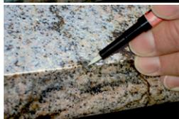
**AKELUX** Primer zur Haftvermittlung auftragen und 60 sec trocknen lassen.
