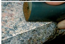
**AKELUX** Silikon-Schleifleinen über den **AKELUX** Schleif- und Polierblock legen und Schadstelle nass feinschleifen.
