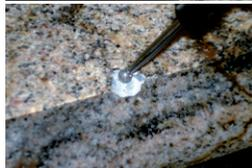
Manuelles oder maschinelles Ausfräsen der Schadstelle, Entfernen aller losen Teile.
