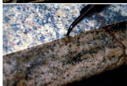
Schadstelle an der Kante mit transparentem Band abkleben. Mit **AKELUX** Filler füllen.
